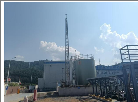
废气处理设施 1
