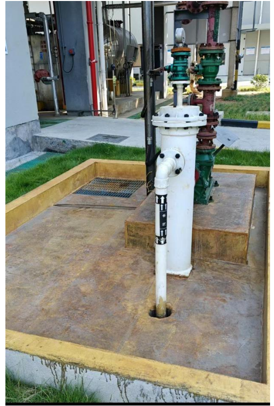
甲类生产车间二污水收集池
